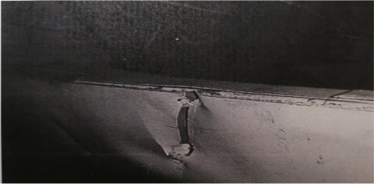
Fotografía No. 8: Fisura de la piel exterior en la aleta inferior de la compuerta del tren principal.
